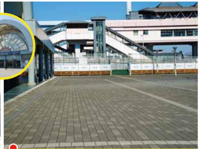
歩道路面に段差・継ぎ目・うねりが多くベビーカー、車いすでの走行は振動を感じる。
