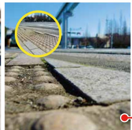
交差点部の横断歩道がある切り下げ構造だが陥没が多くあり。
